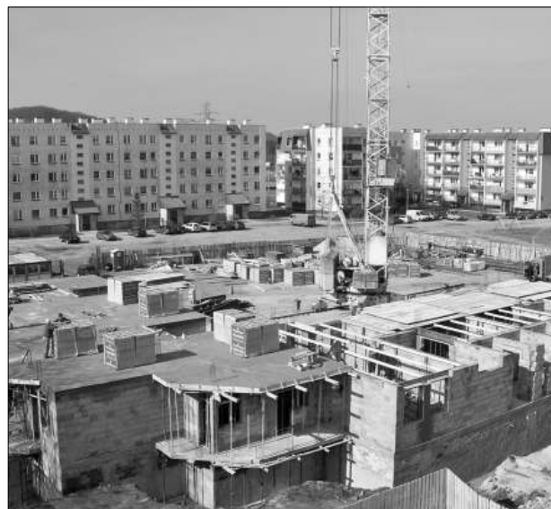
Budowa bloku LTBS-u przy ul. Lasaka
